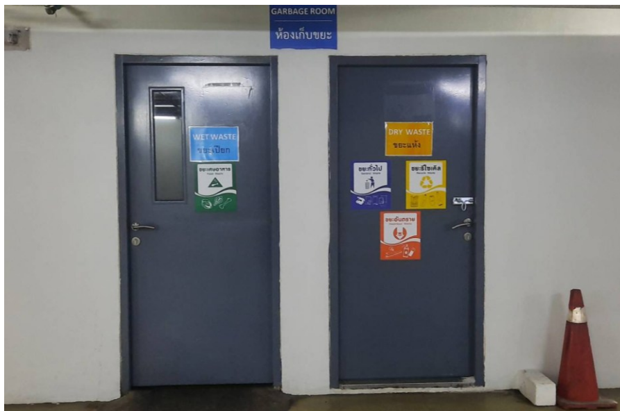
ที่ 5-15 ประตูห้องพักมูลฝอยรวมปิดไว้อย่างมิดชิด
